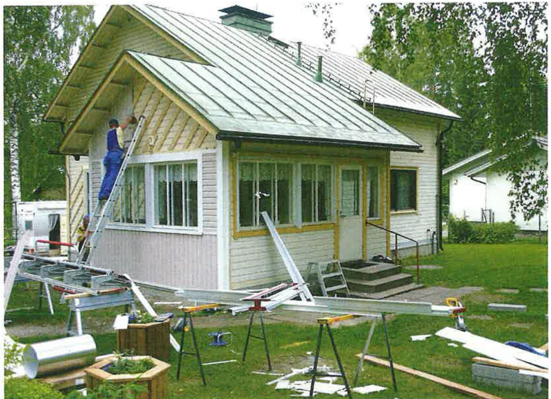
PVC-ELEMENTIT asennetaan koolauksen päälle. Ikkunat pellitetään asennussarjaan kuuluvalla materiaalilla. Edessä näkyvät asennuspöydät ovat myös Kaycan- tuotteita.
