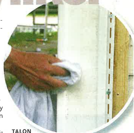
TALON kulma puhdistuu kevyesti pyyhkimällä. Valkoiset kulma- ja reunalistat ovat vinyyliä ja kuuluvat yhteen asennettävien paneelien kanssa.
