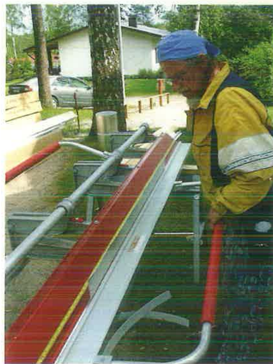
RAIMO Hassinen taivuttaa ikkunan aluspeltiä. Materiaali taipuu kätevästi maahantuojan toimittamalla työkalulla.
